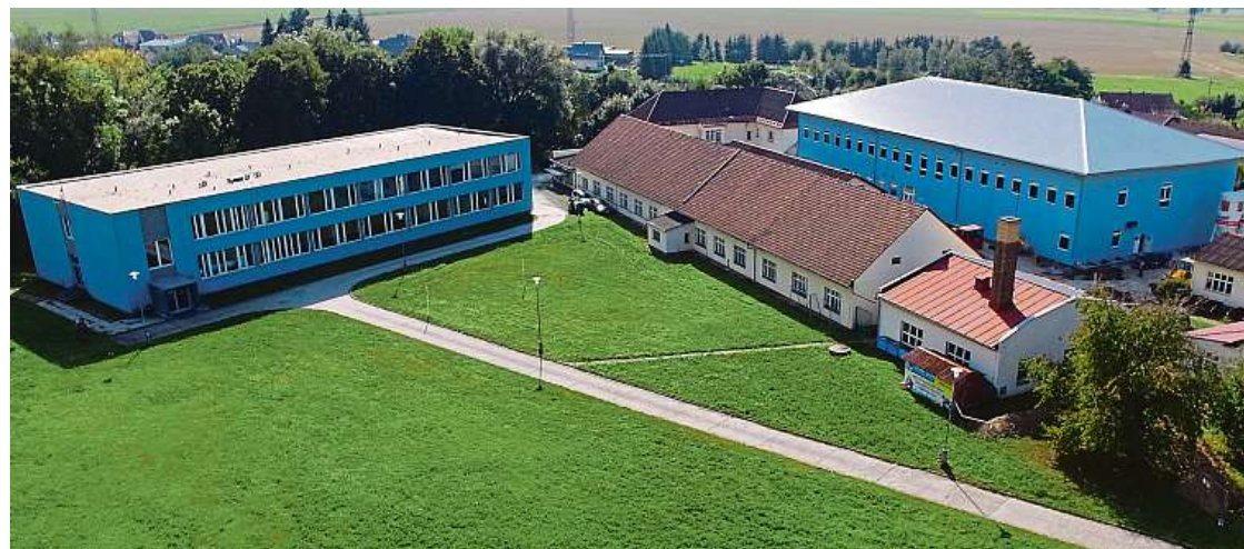
Výstavba nových prostor školy s moderními pracovišti (modrá budova vpravo) se chýlí ke konci. FOTO | ARCHIV ŠKOLY
